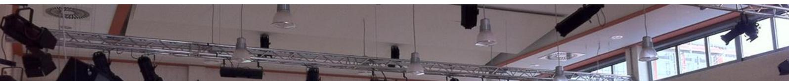
Die Verkabelung der Scheinwerfer erfolgt in Serie pro Traverse. Das gilt sowohl für den Netzstrom als auch für den DMX-Bus. Als Unterstützung der Ausführungsplanung kann ein individuelles Verkabelungsschema von uns für den Auftragnehmer erstellt werden.
